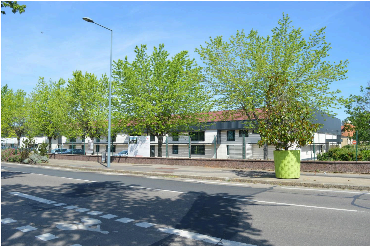
Ancien site de l'Usine de Tubize - Parc d'activités du Moulin à Vent - Avenue du Dr Georges Lévy - mai 2022
