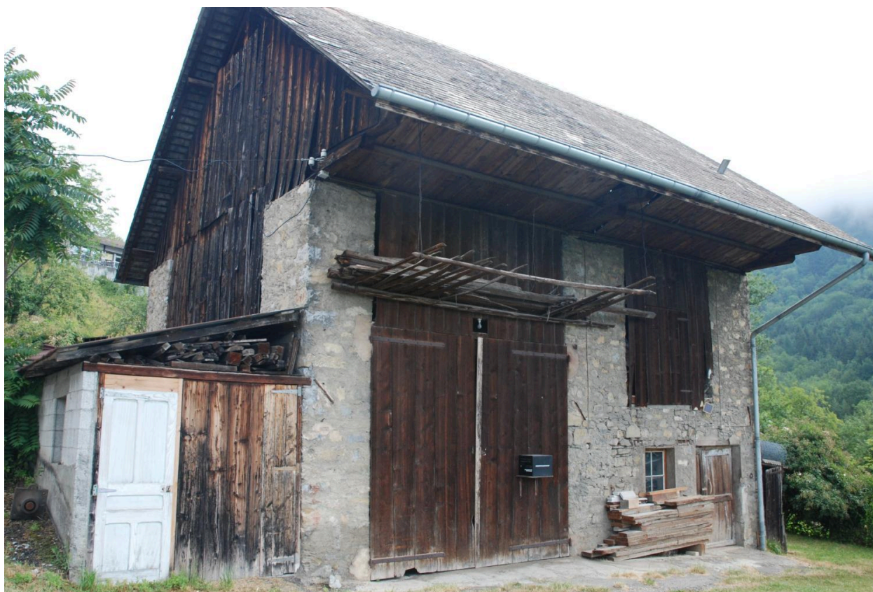
[Partie sud] Grange-étable (2018 YK 91).
