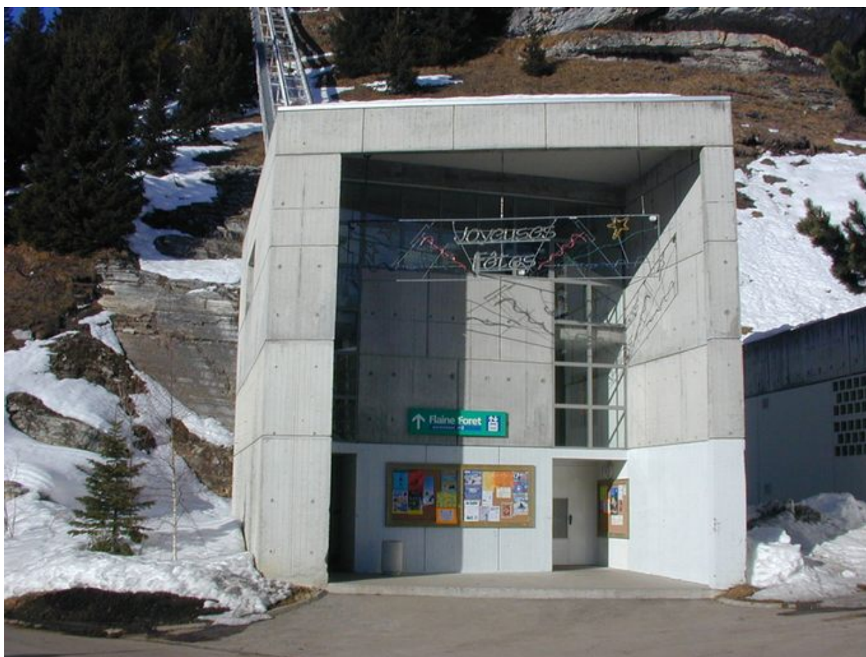
Elévation principale de la gare inférieure, vue depuis le sud
