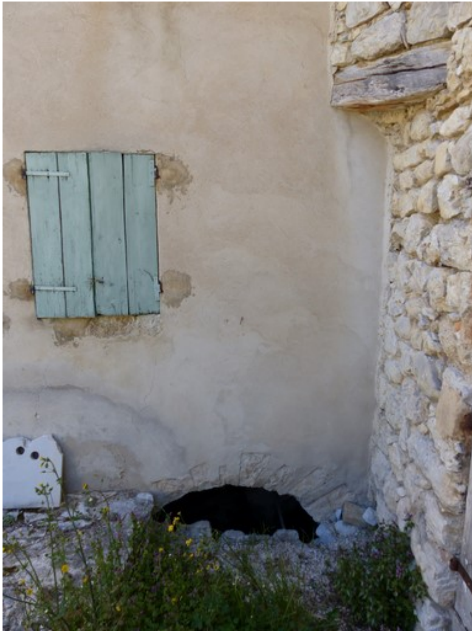
Bâtiment principal. Pignon sud, angle est. Ouverture de la chambre de la roue.
