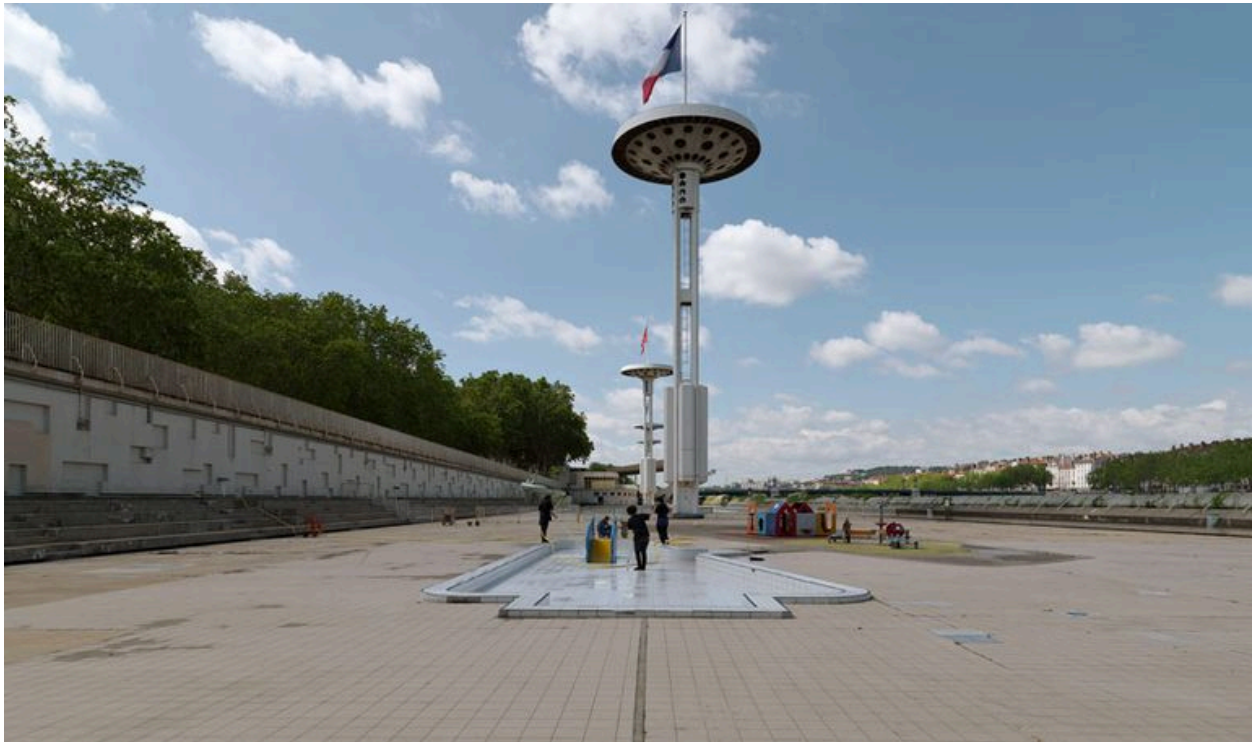
Vue de la partie nord de la piscine : l'ancienne patinoire (état juin 2012).
