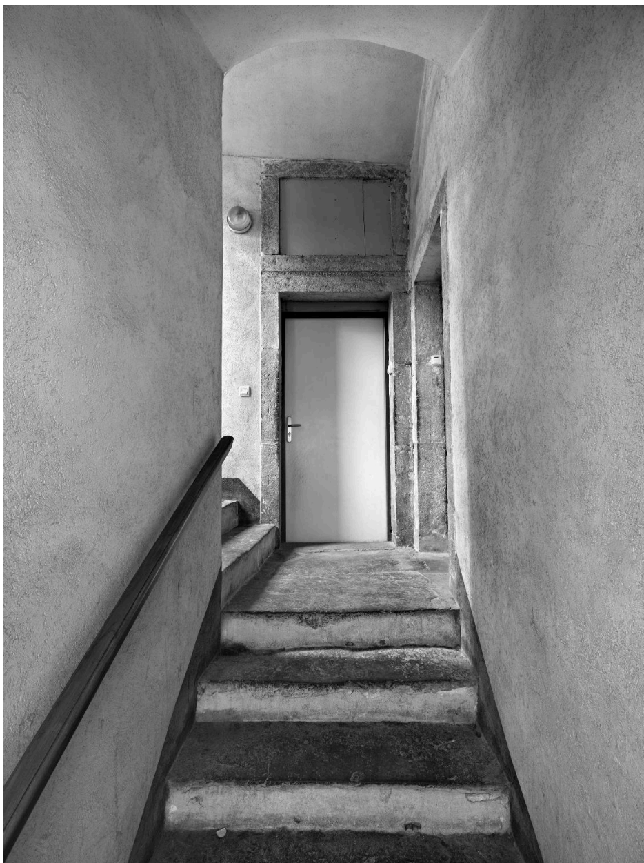
Maison, immeuble, 48 à 58 rue Louis Blanc-Pinget (2018 E1 350). Bâtiment sur cour. Logements : escalier, palier du 1er étage.
