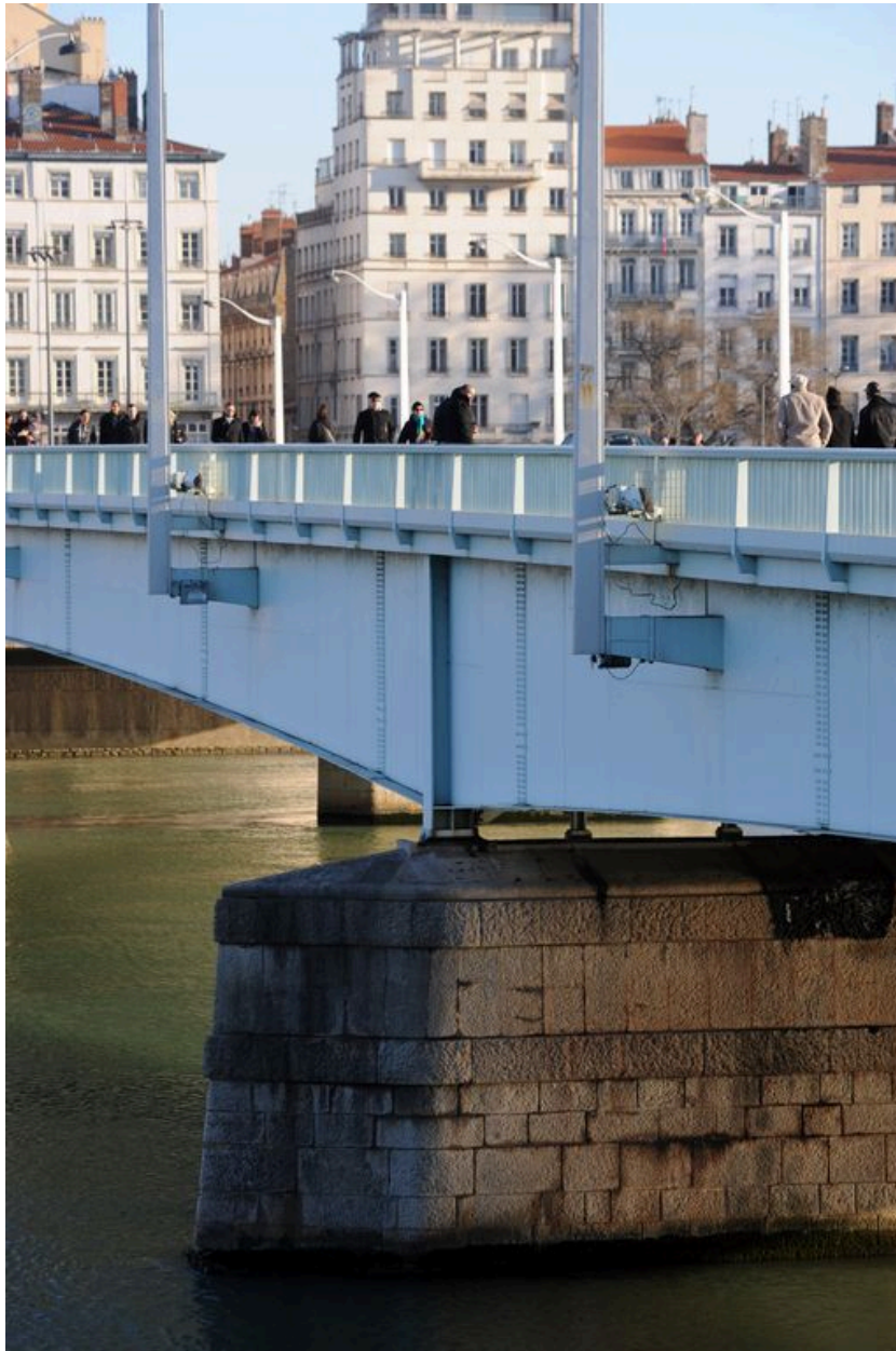
Pile, de côté, face amont, vue partielle : moitié (depuis la rive droite)
