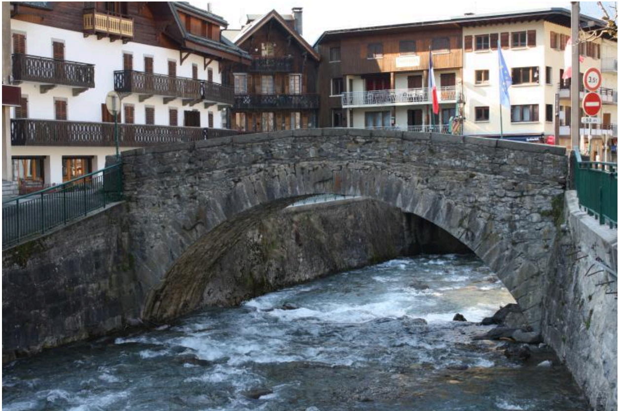
Vieux pont de Morzine, face amont
