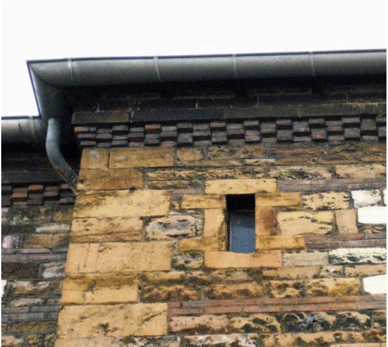
Élévation principale, détail de la corniche
