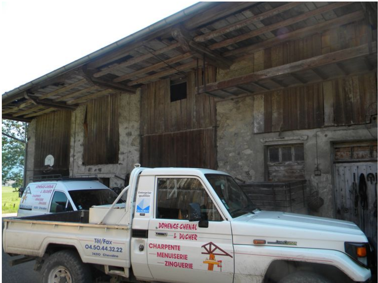
Façade principale du bâtiment agricole avec séchoir à noix suspendu.
