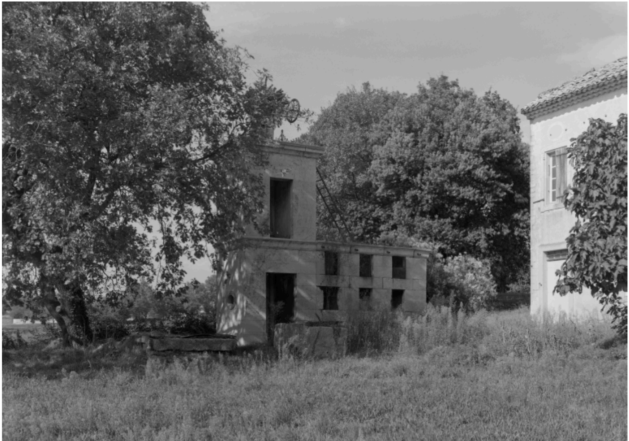
Eautagne du Cours (Route Nationale n° 541). Maison (D3 451) : le puits, anciennement activé par une éolienne, et les clapiers.
