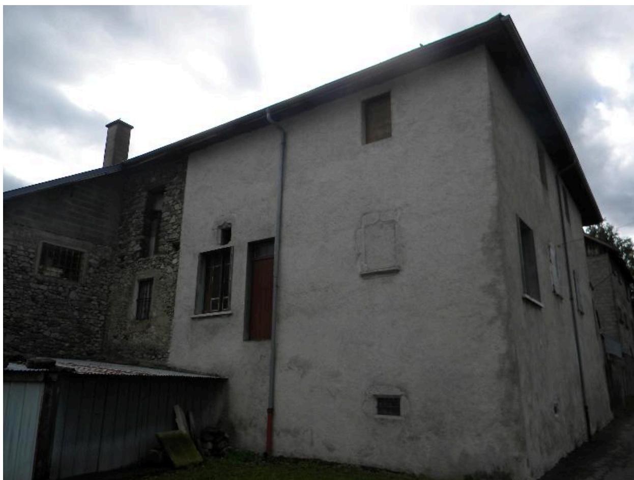
Vue des façades nord et ouest
