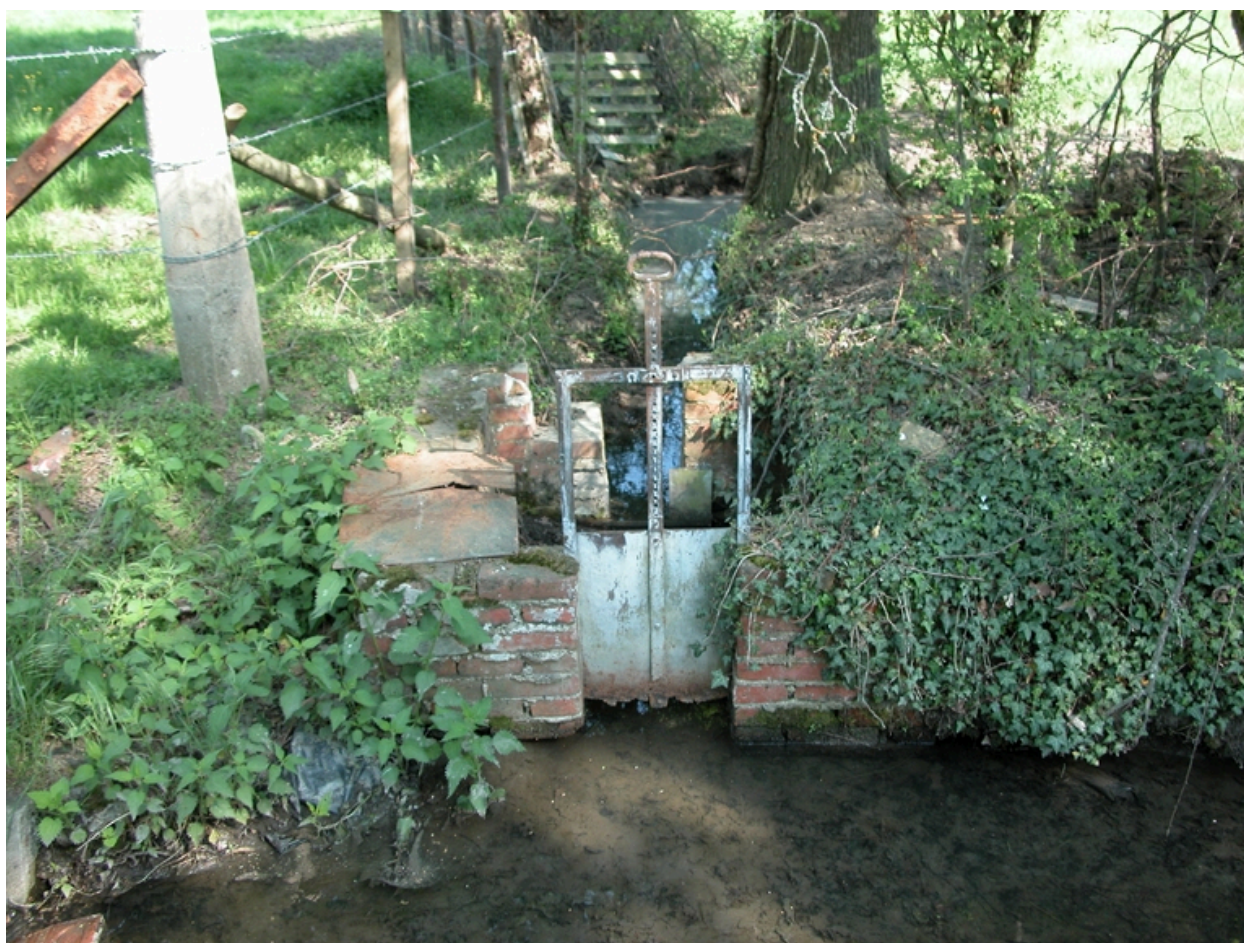
Artériole du canal du Forez à Chantegrelet : vanne (section 1997 AL).
