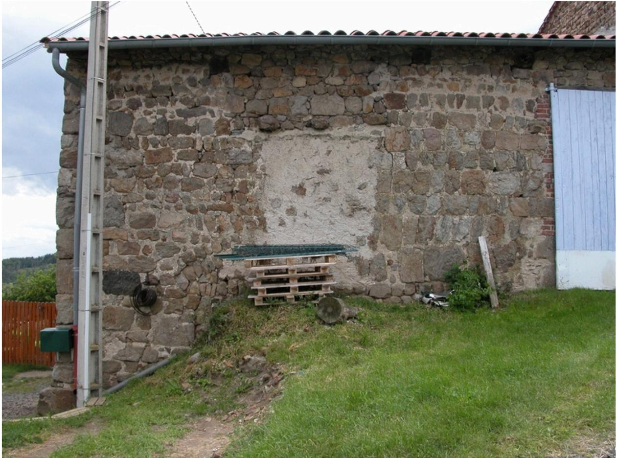
Vue du mur nord de la grange (moellon sur chant, accès par montoir et en utilisant la pente naturelle).
