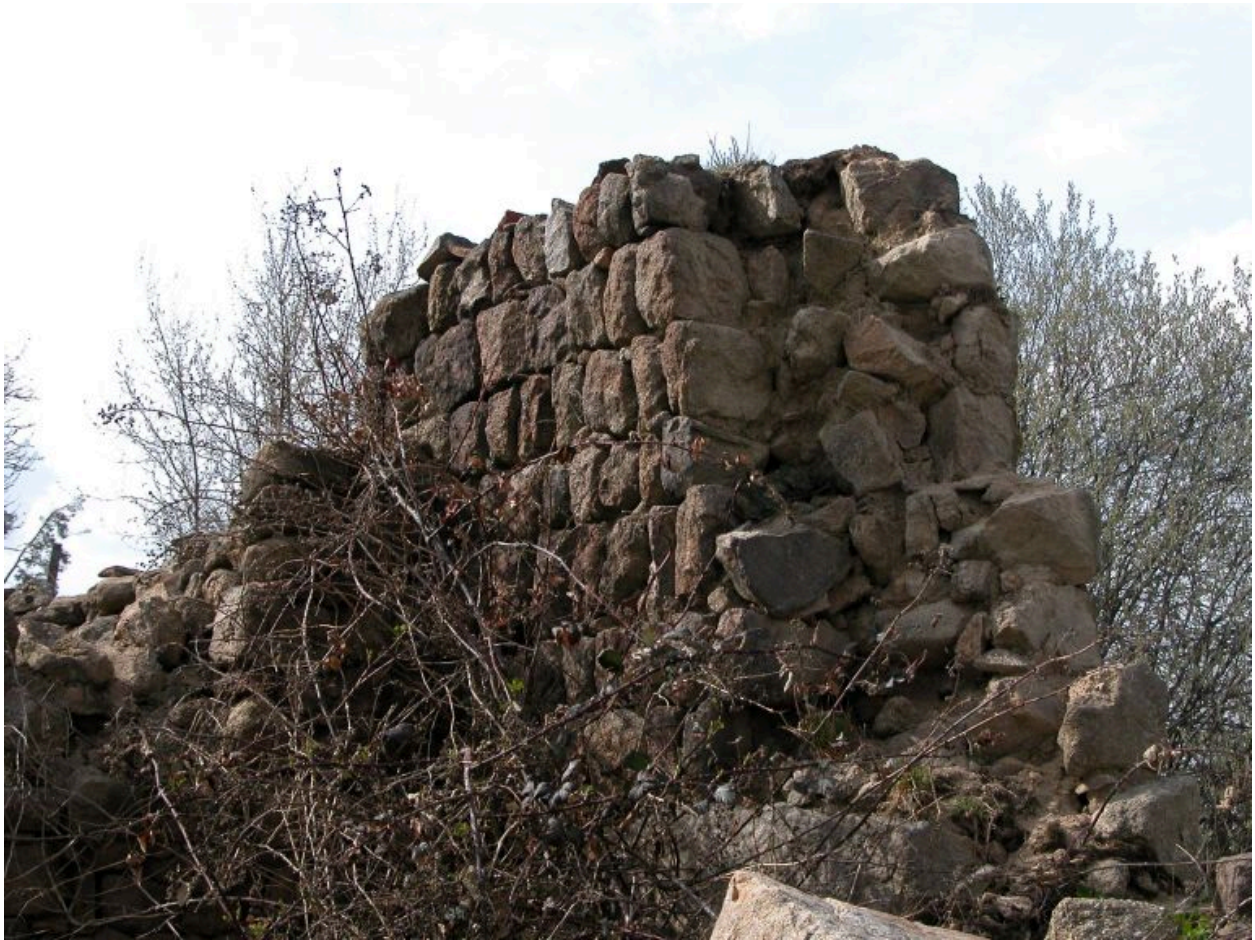
Contéol, F 269. Ferme en ruine, détail de construction d'un mur en pierre.
