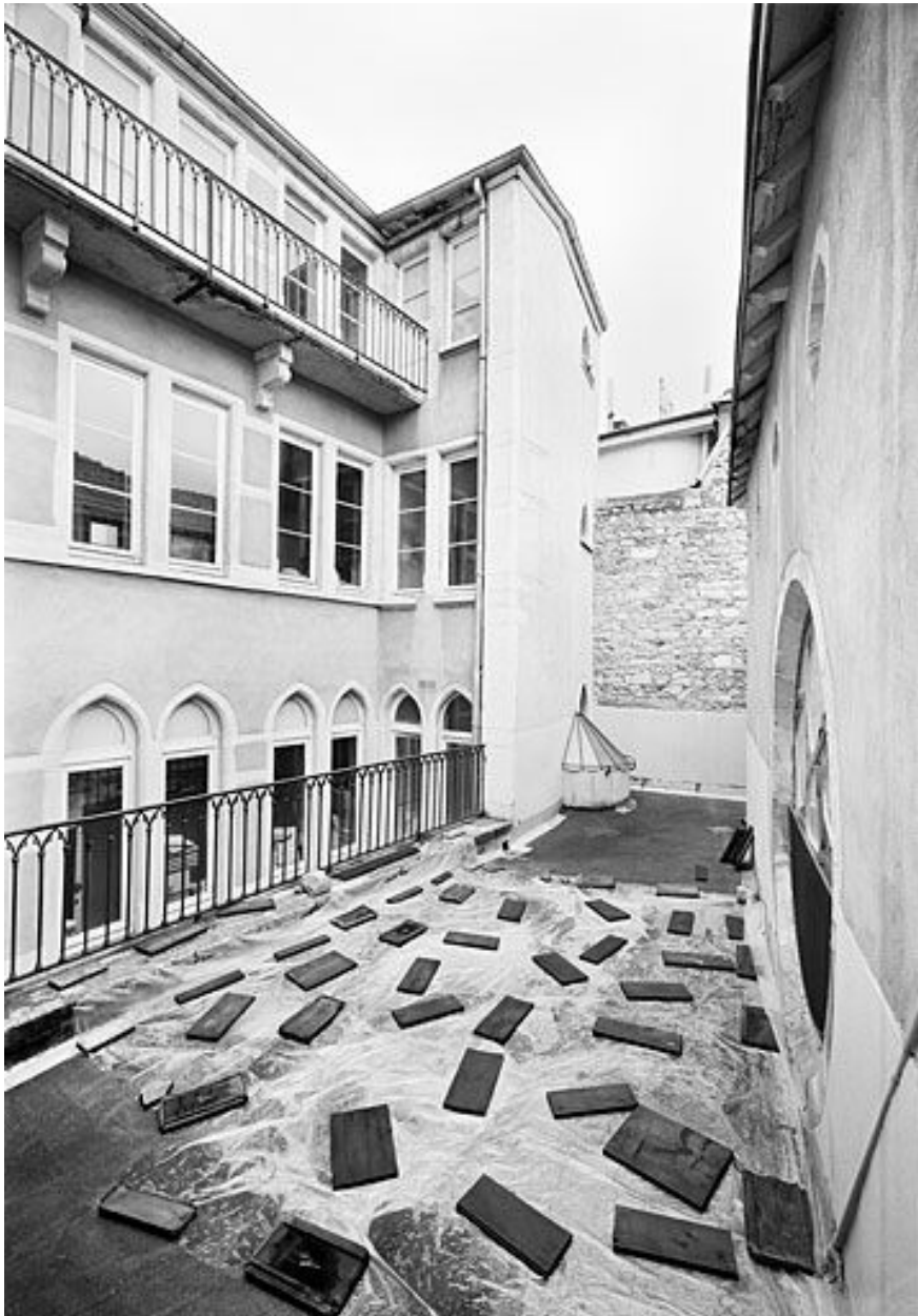
Bâtiment à étages, élévation postérieure vue depuis la terrasse couvrant l'église
