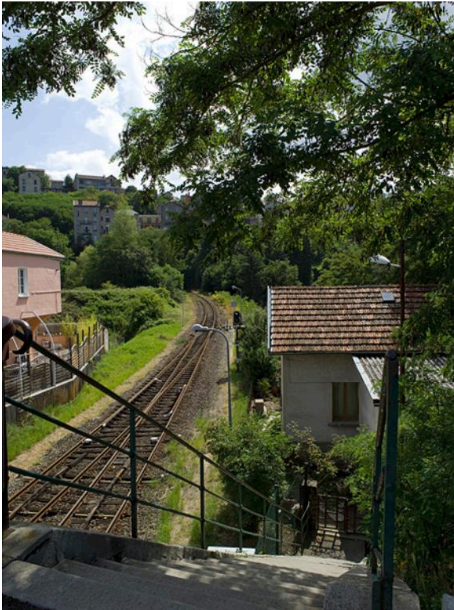
La voie ferrée depuis le haut des escaliers de la rette.
