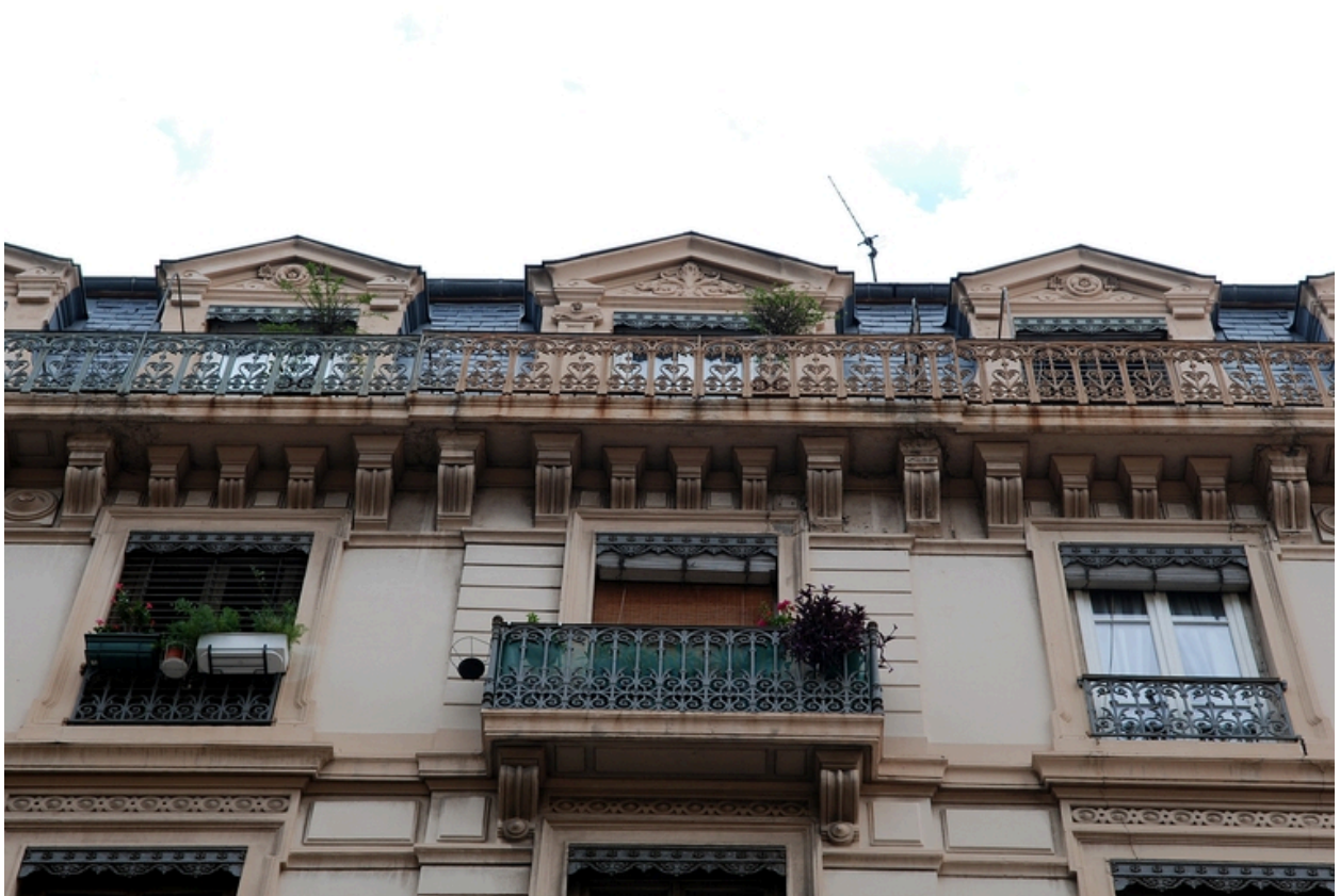
Elévation rue Gasparin : l'étage de comble
