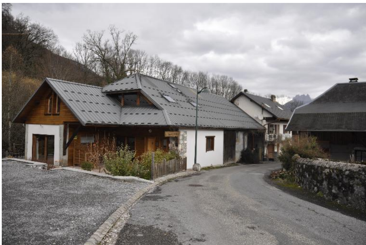
Vue du bâtiment de la remise après les travaux de rénovation
