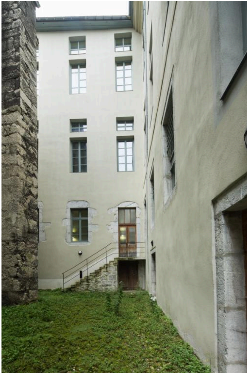
Espace de transition entre l'aile C et la chapelle. Vue prise depuis le portail sur rue.
