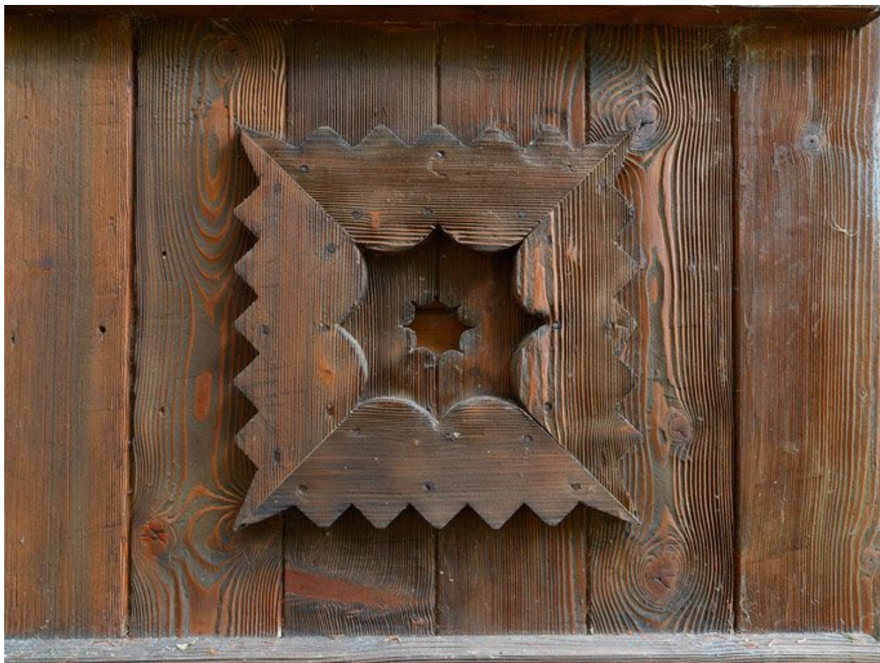
Détail d'un décor de façade
