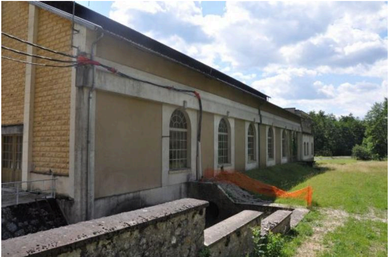
Vue de la façade nord de la centrale.
