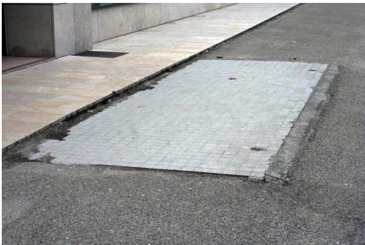
Socle d'un des portiques
