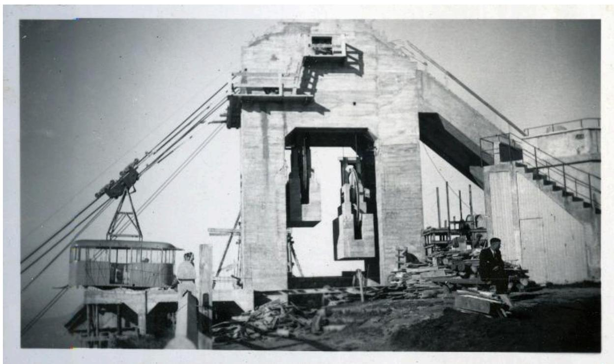
Partie technique en construction, 1935 : cabine, contrepoids et poulies de renvoi
