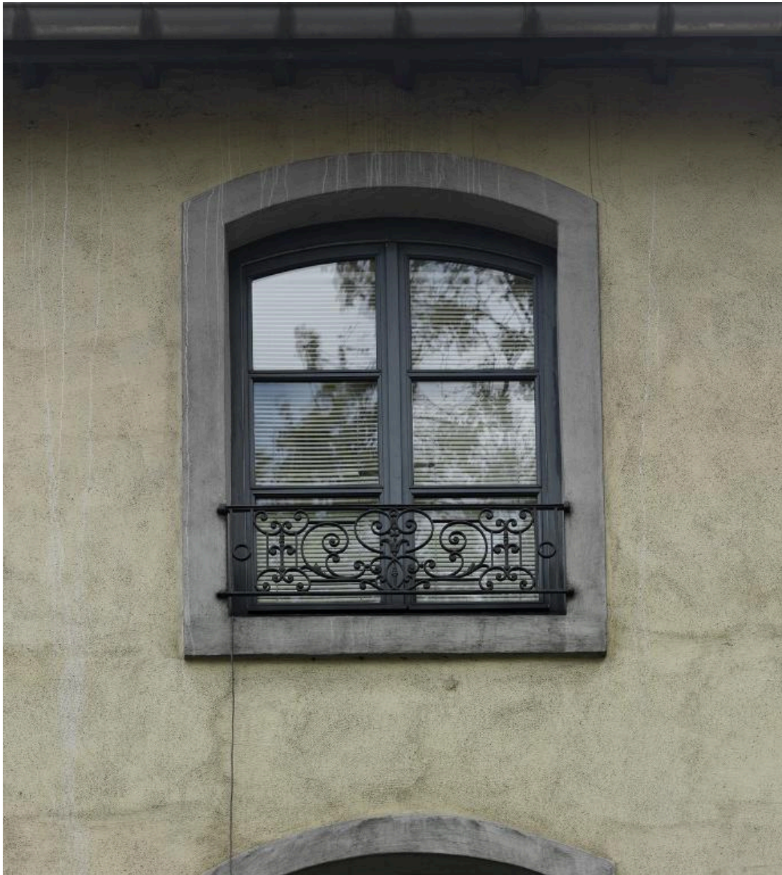
Elévation postérieure, 1er étage, détail d'une baie
