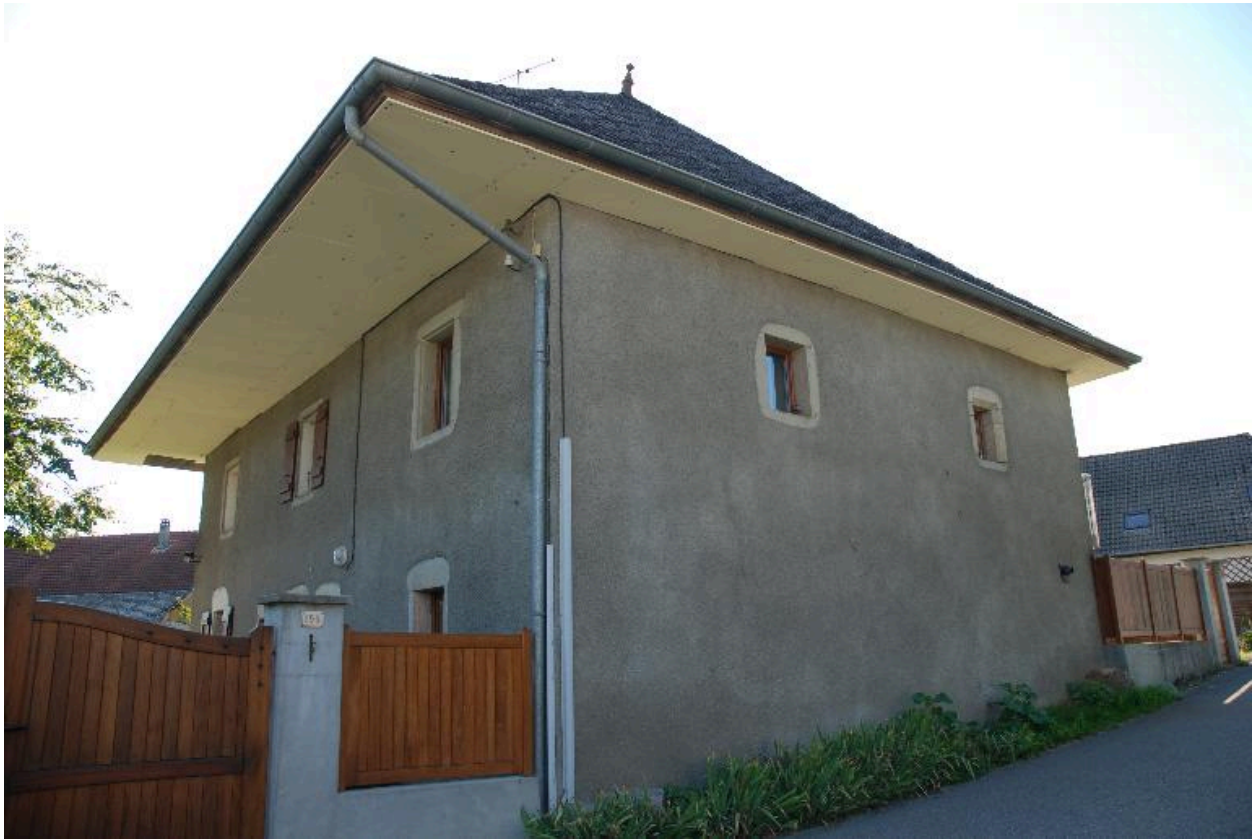
Vue d'ensemble de l'habitation depuis la route du Chef-lieu.
