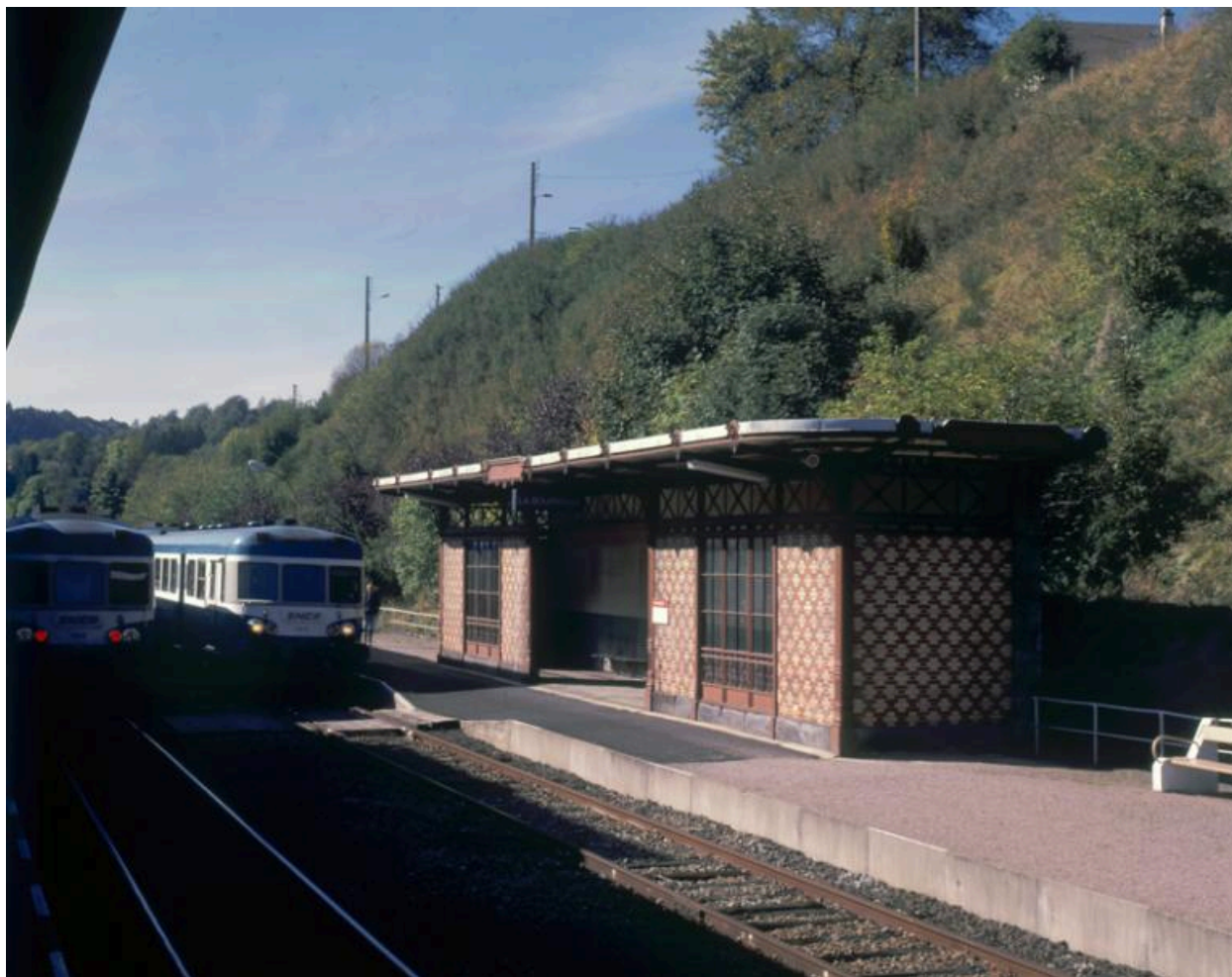
L'abri de voyageurs du quai n°2, en gare de La Bourboule.
