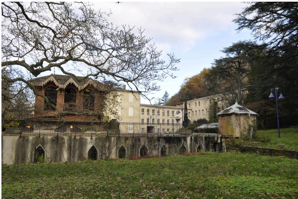
Parc soubassement pavillon
