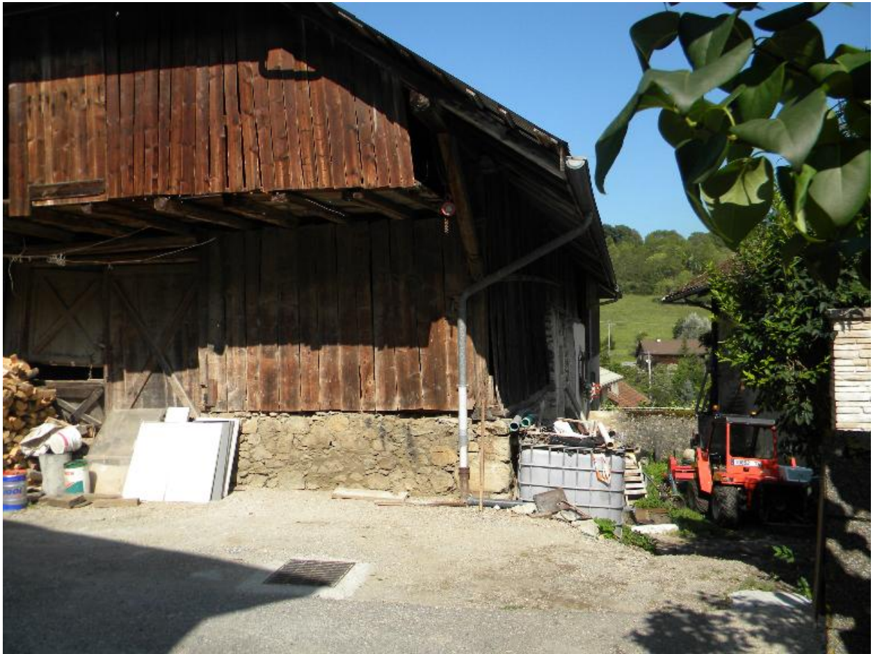
Vue de la façade arrière.
