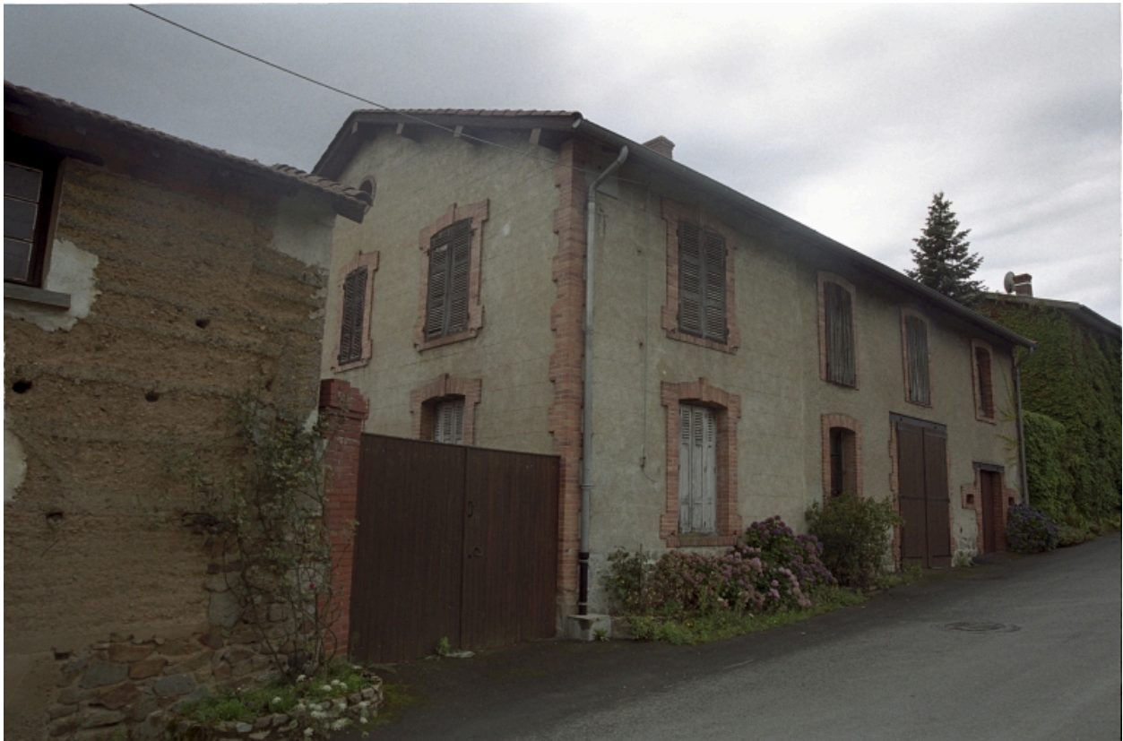
Leigneux, le Garet (1987 A1 824), type C1. Vue d'ensemble du logis et du cuvage.
