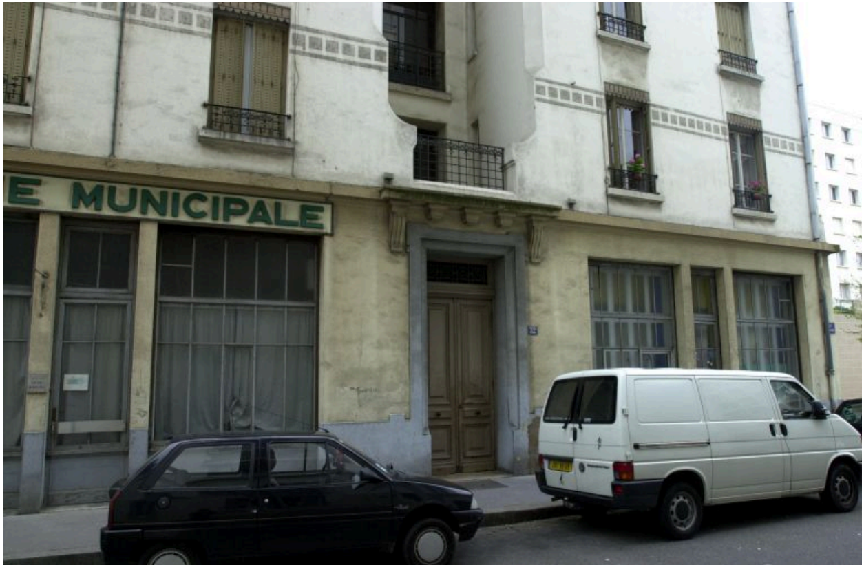
32 rue Quivogne, le rez-de-chaussée
