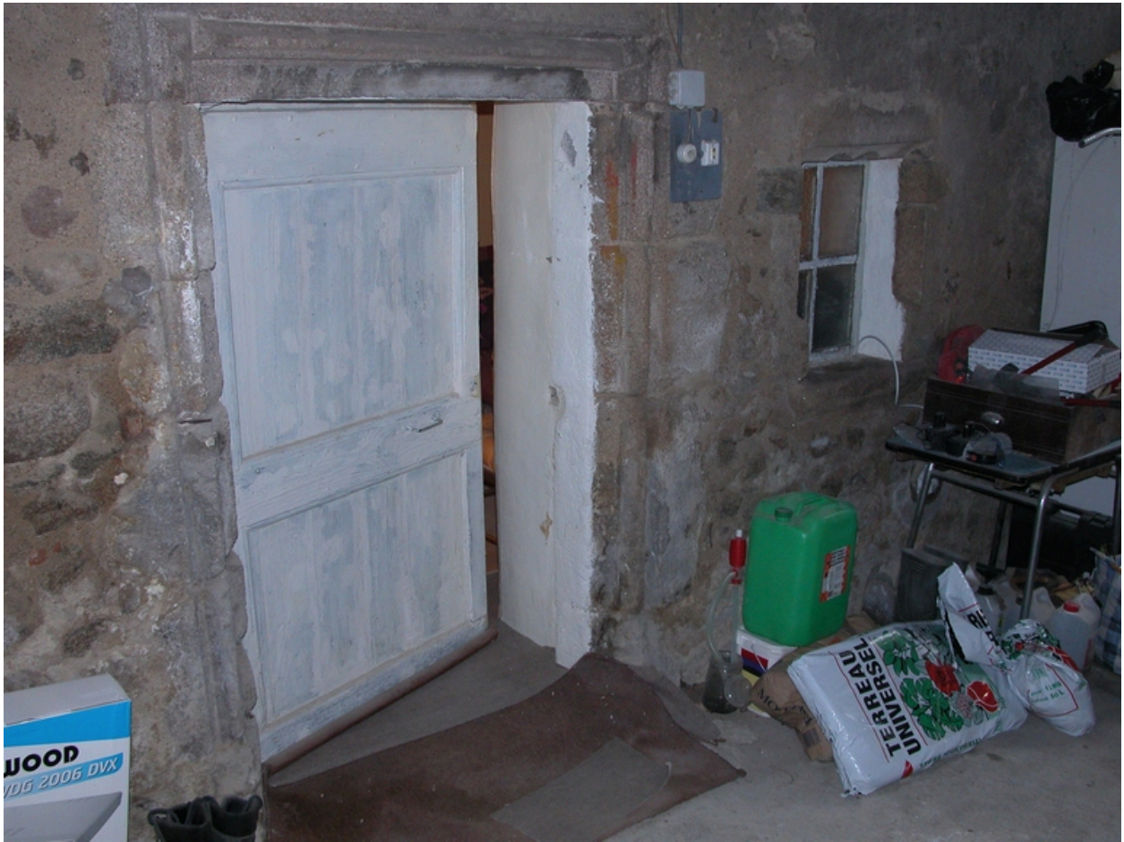
Vue intérieure de la parcelle 1984 E 123, maison de gauche : encadrement de porte du 16e siècle.
