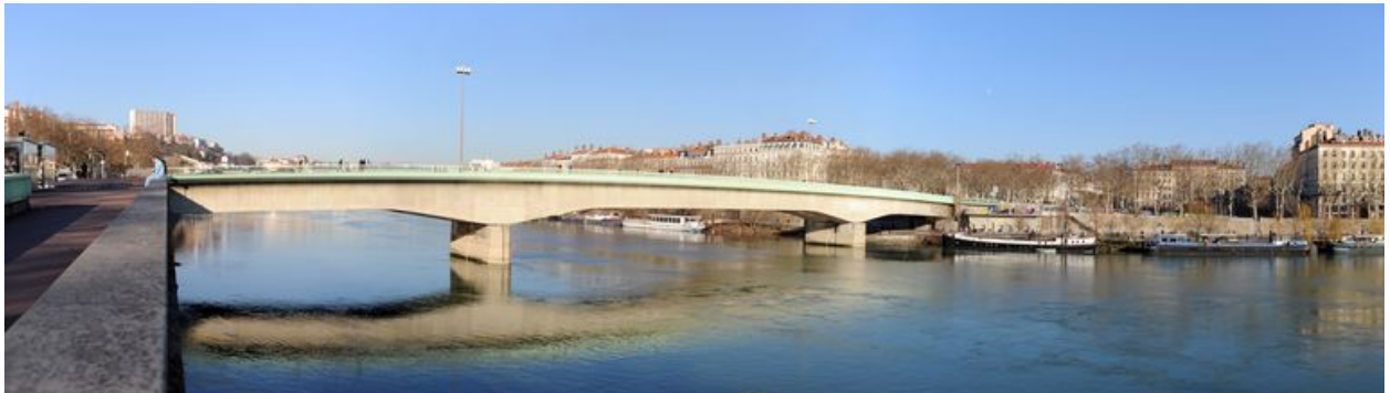
Vue panoramique, face aval (depuis la rive droite)
