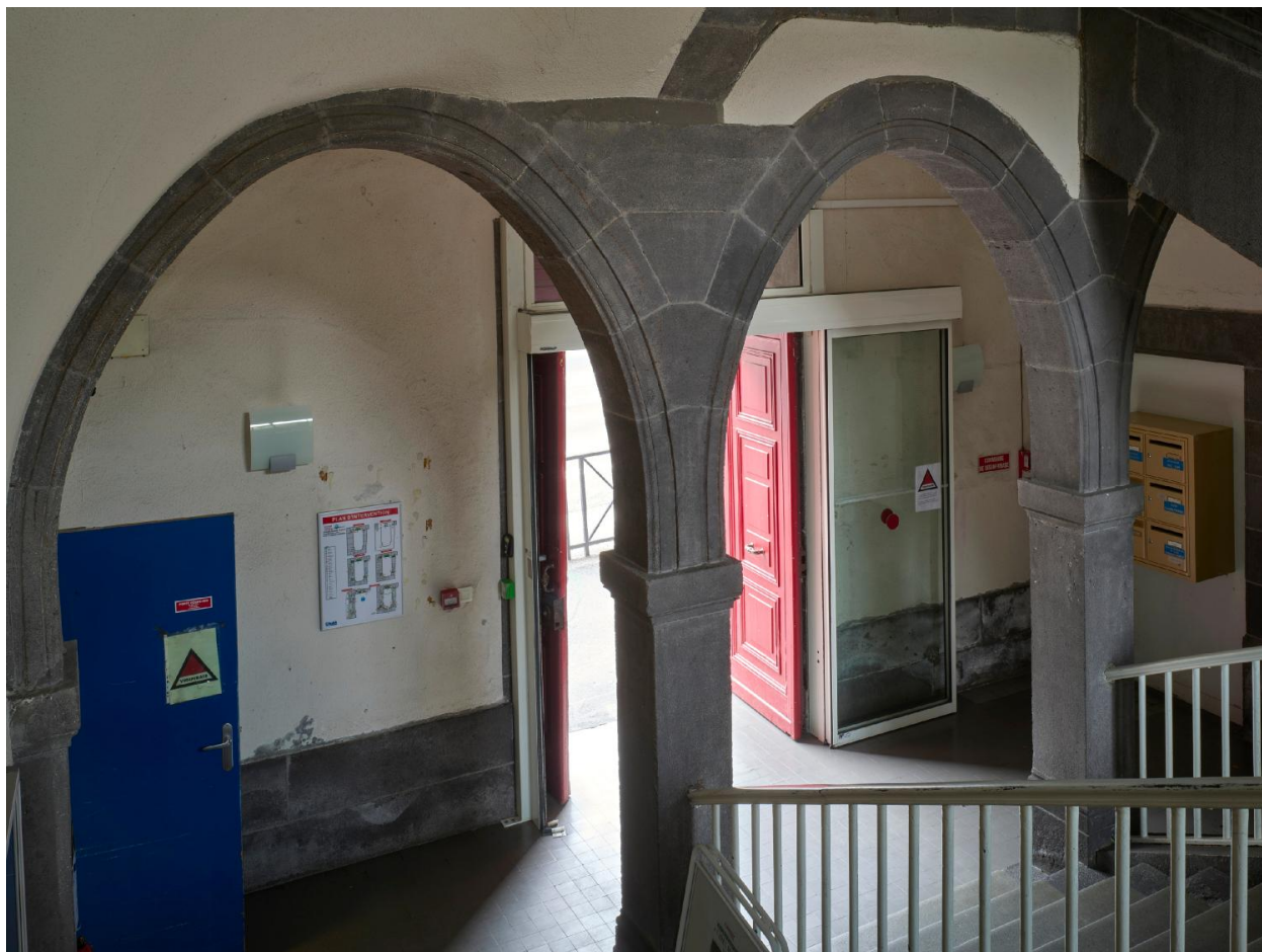
Vestibule de l'entrée principale, rue Maréchal-Joffre
