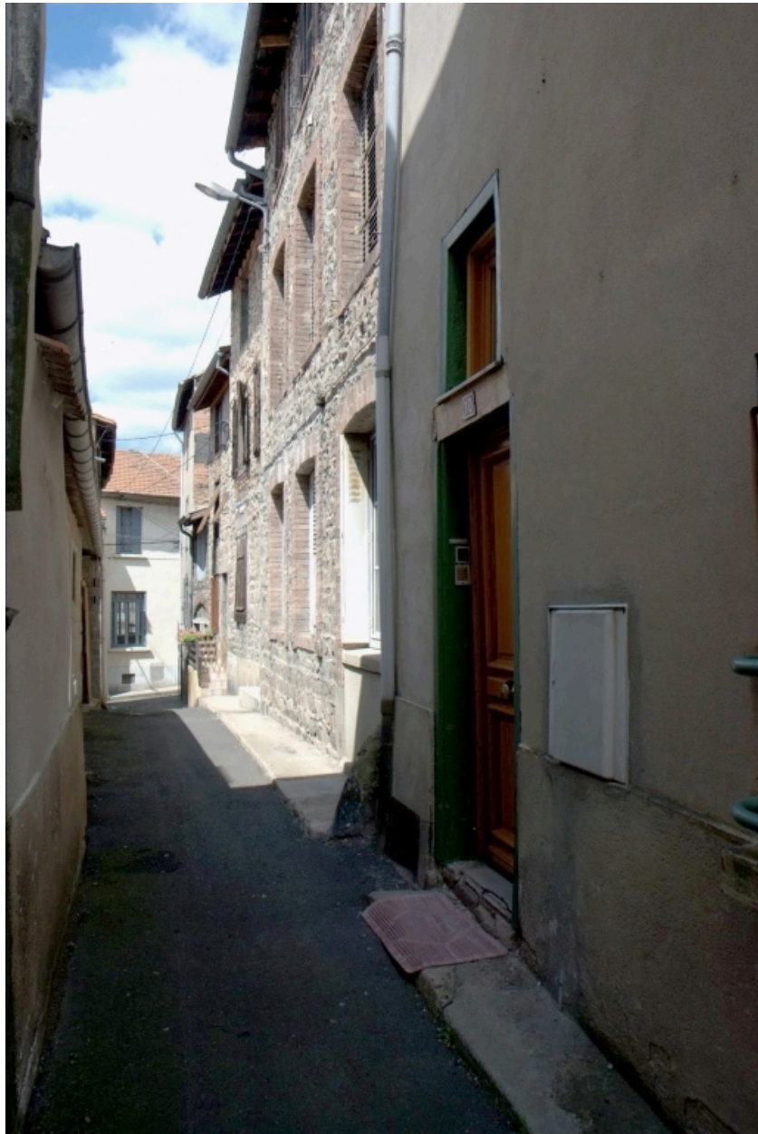
Îlot 5. Vingtains (rue des). Vue générale des façades sur rue
