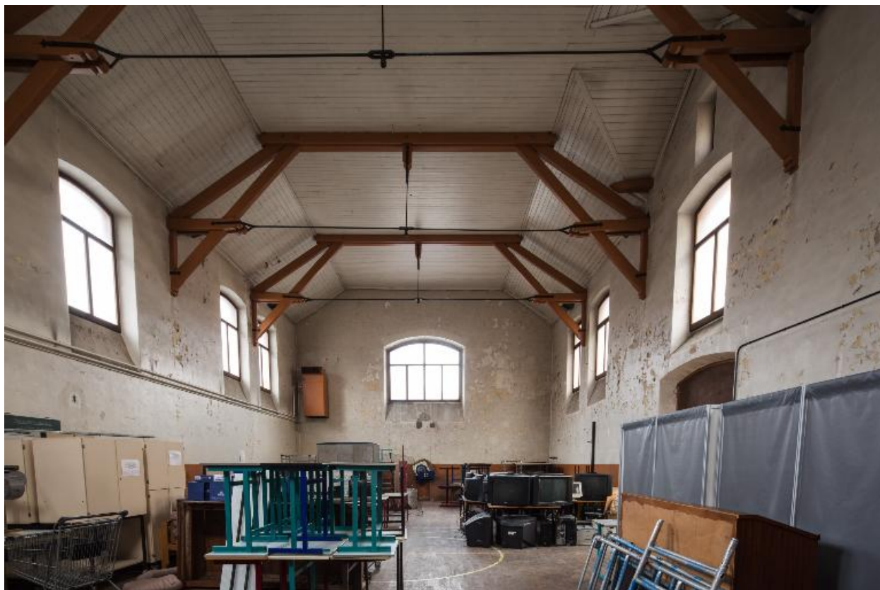
Cour nord : ancien gymnase, vue intérieure, vers l'est.
