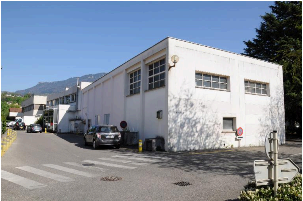
Chaufferie (bât. L) et blanchisserie (bât. M)
