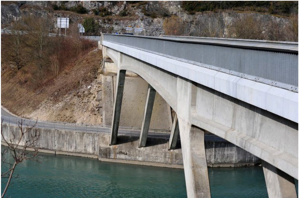
Vue partielle, de côté, face aval (depuis la rive gauche)
