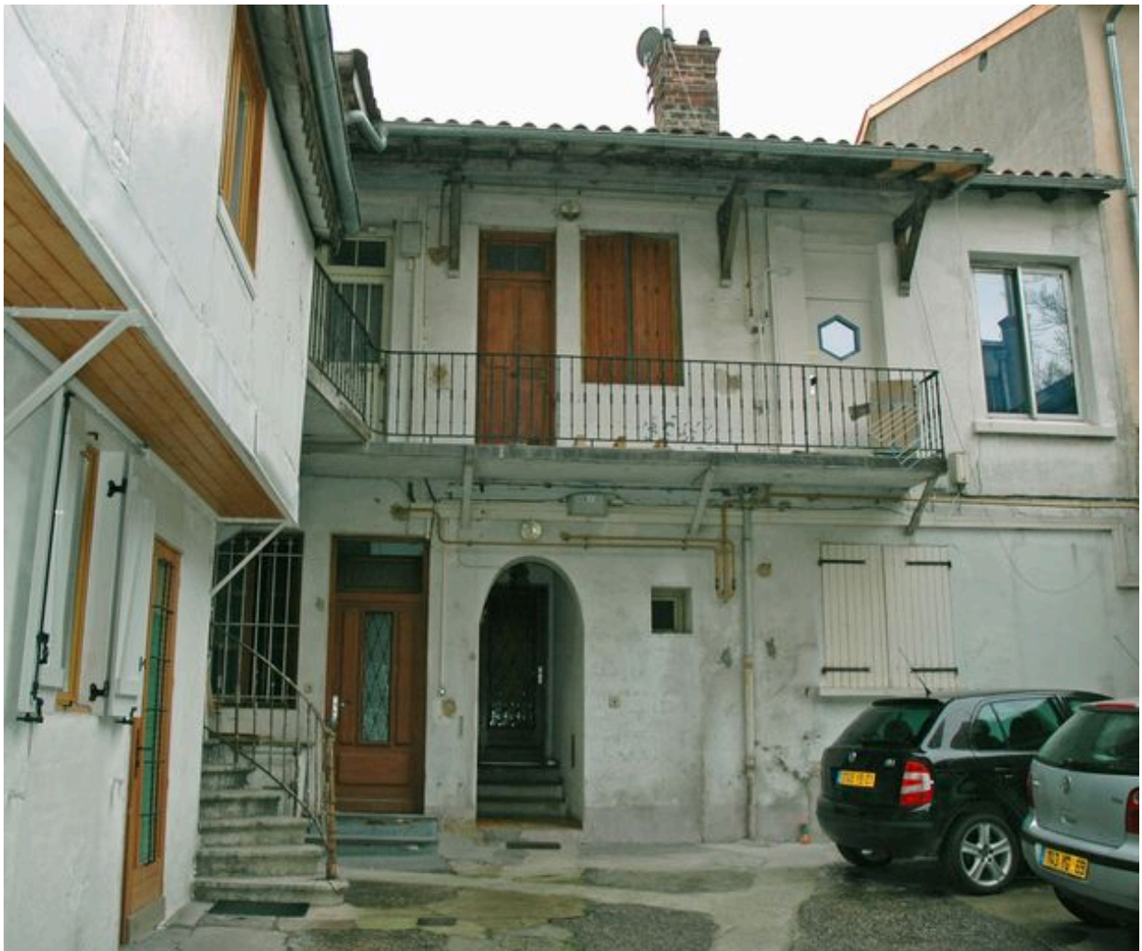
Façade ouest du corps de bâtiment en fond de cour, vue depuis le passage couvert à l'ouest
