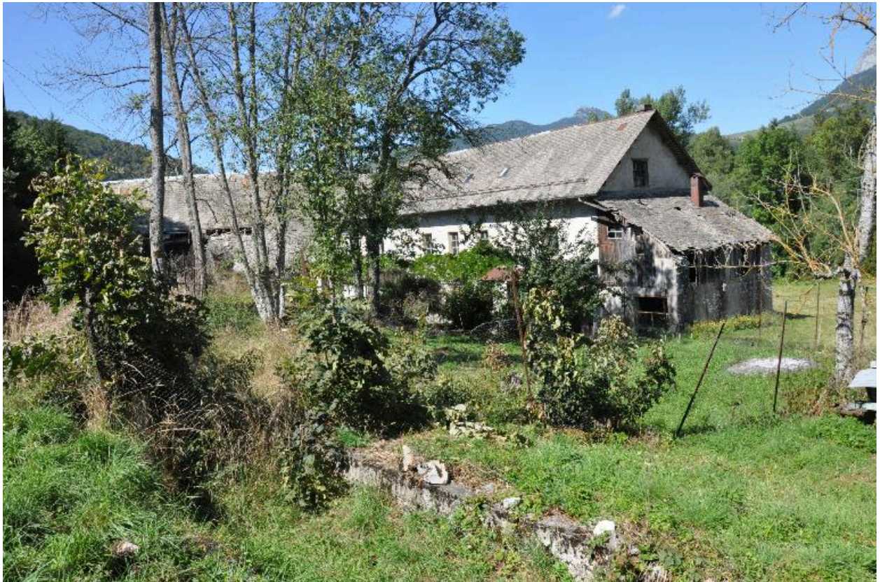
Vue générale du site.
