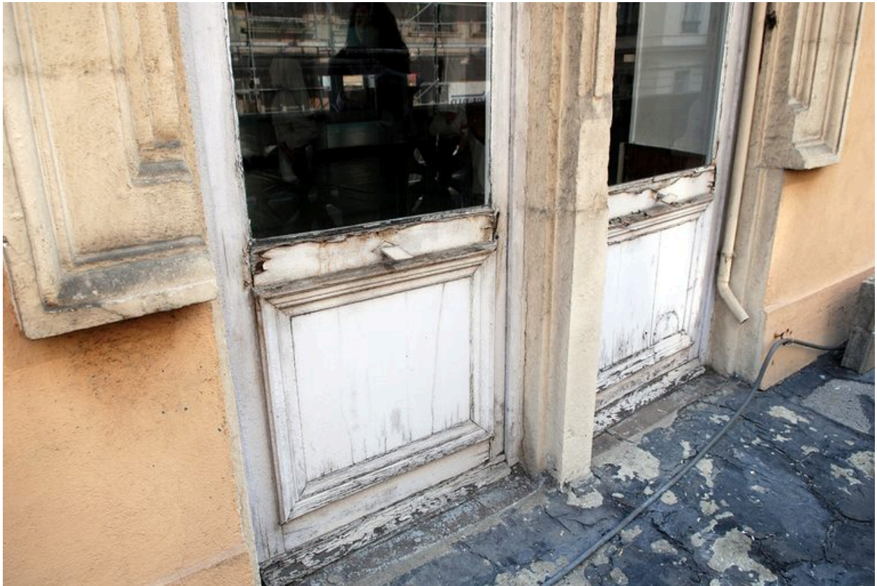
Elévation ouest : 1er étage carré, fenêtre transformée en porte-fenêtre
