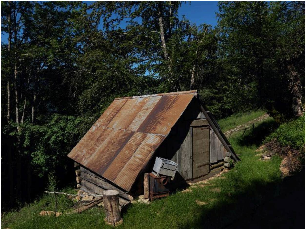
Vue d'ensemble (côté amont).
