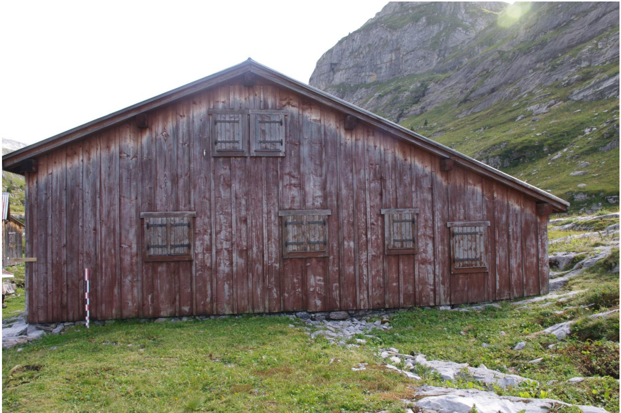
Vue de la façade latérale nord
