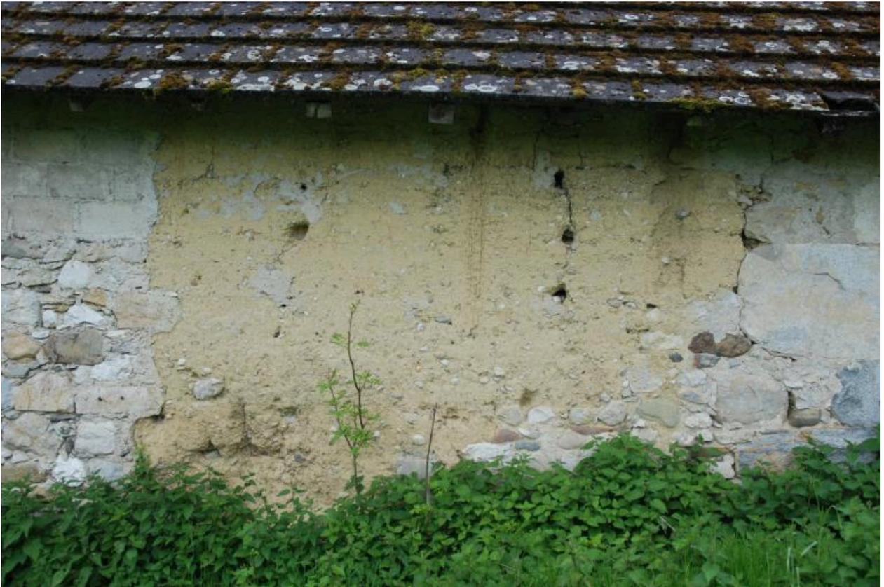
Détail de l'élévation postérieure : mur de la grange, en pisé.
