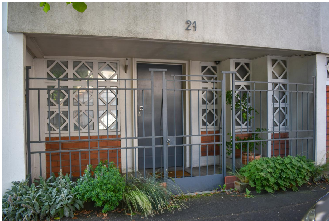
Porte d'entrée sur le boulevard
