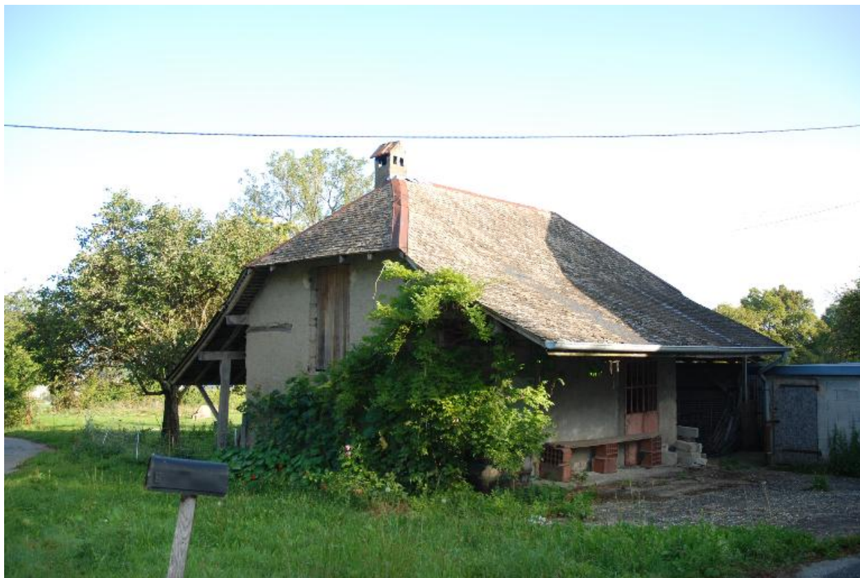
Vue du four à pain.
