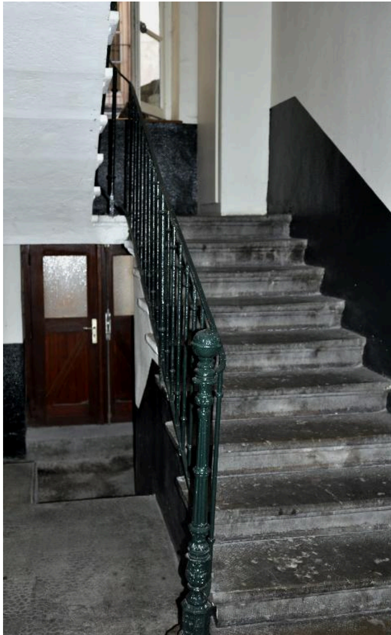
Vue intérieure : le départ de l'escalier
