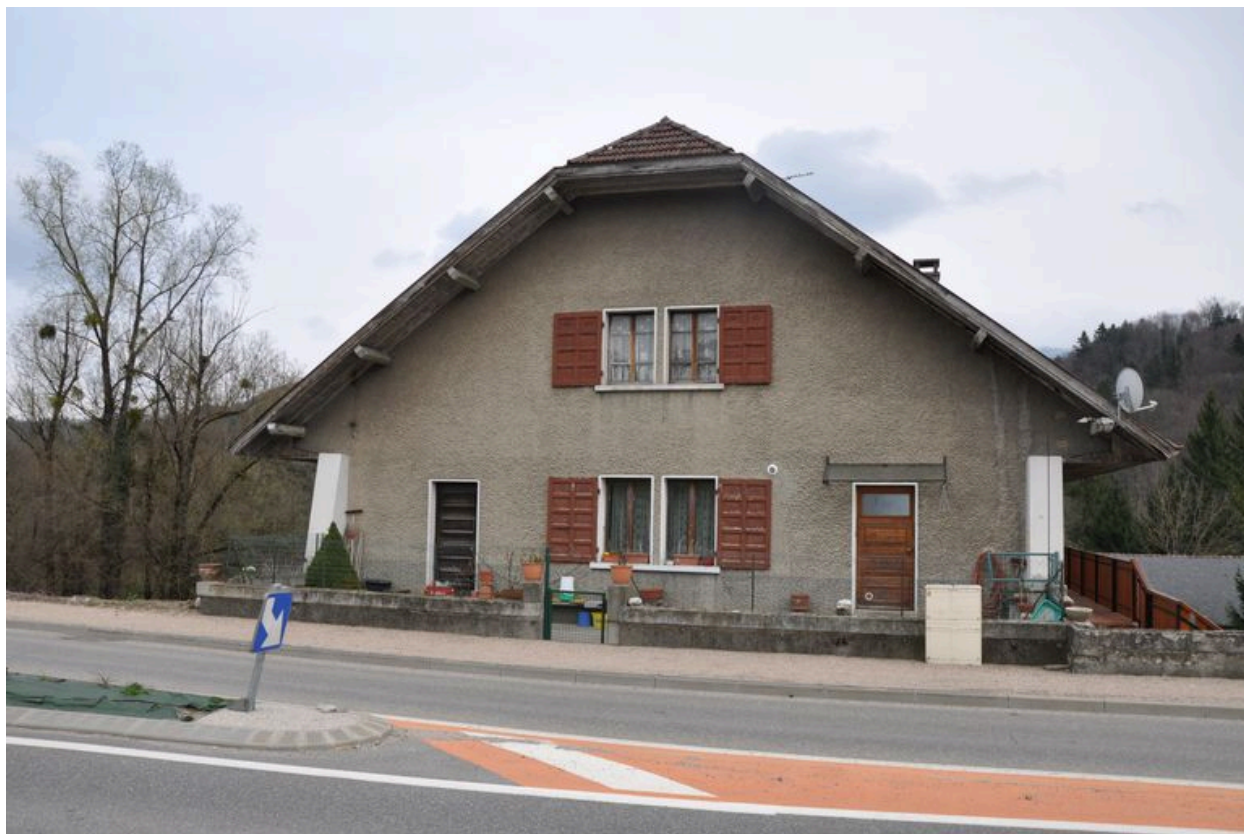
Vue du mur pignon ouest prise depuis la route d'Annecy
