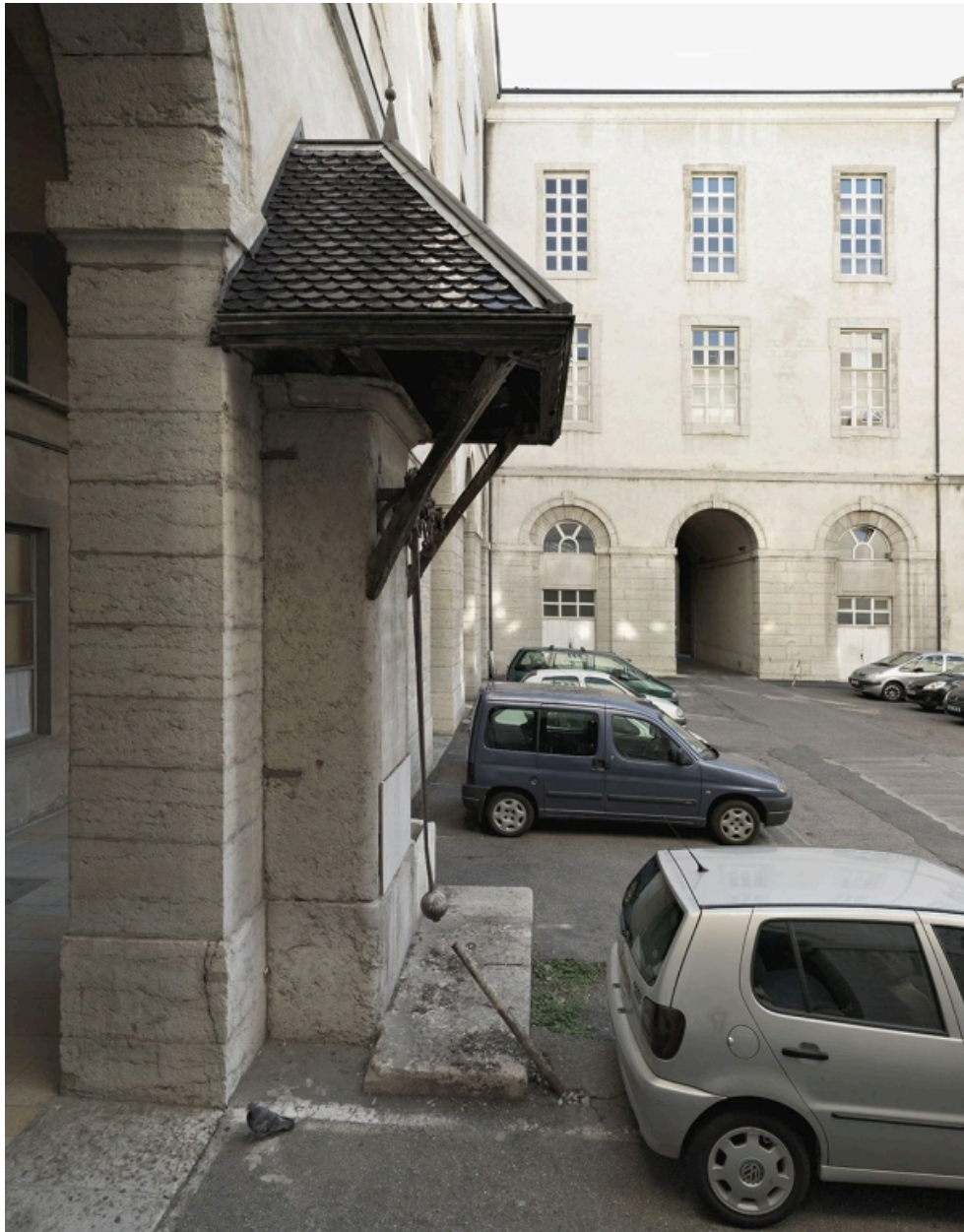
Le puits de la cour de la Chaufferie. Vue depuis le nord
