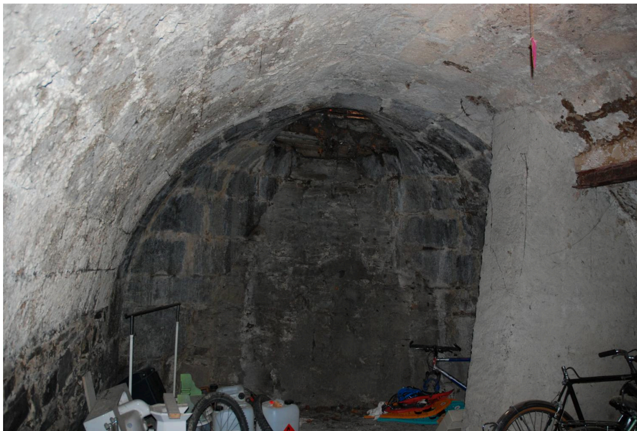
Vue intérieure de la cave.
